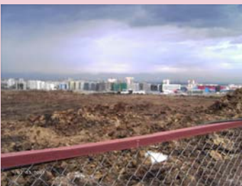
In Bulgarien wird rege gebaut. Hier entsteht ein komplett neuer Stadtteil.
