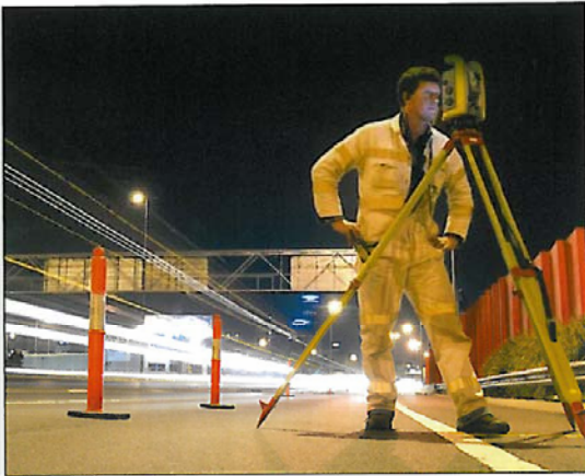
Die Vermessungsarbeiten am Westgate Freeway in Melbourne wurden Tag und Nacht durchgeführt
